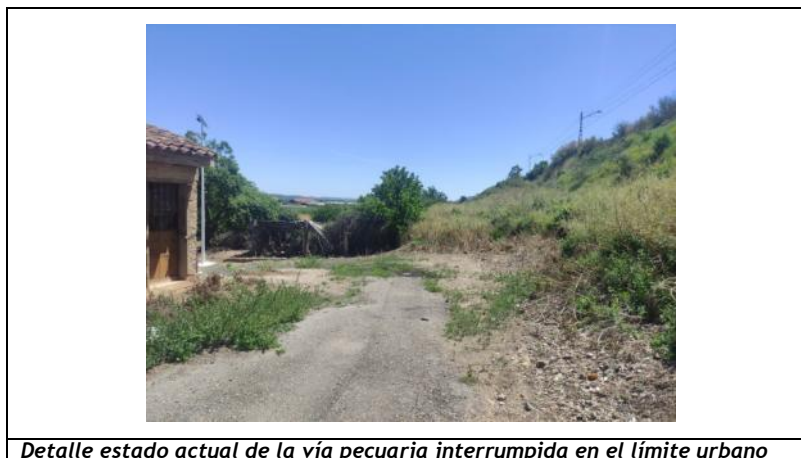
Detalle estado actual de la vía pecuaria interrumpida en el límite urbano
