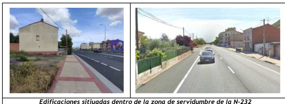
Edificaciones situadas dentro de la zona de servidumbre de la N-232
