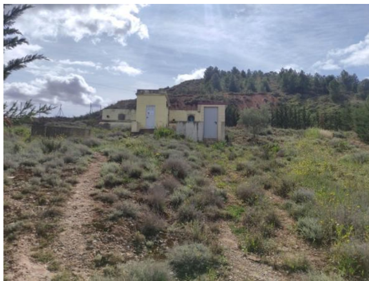
Depósito de Atalayuela
