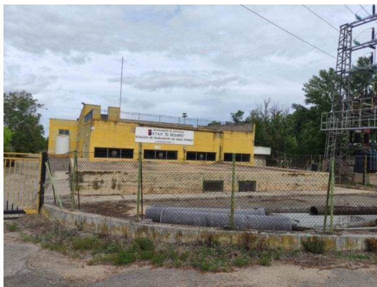
ETAP situada en la margen derecha del río Ebro
